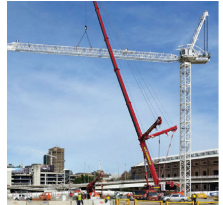
Montaje de una grúa abatible Liebherr 542 HC-L en Darling Harbour, Sydney
